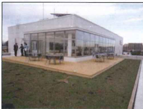
屋上緑化(入間ガス)
